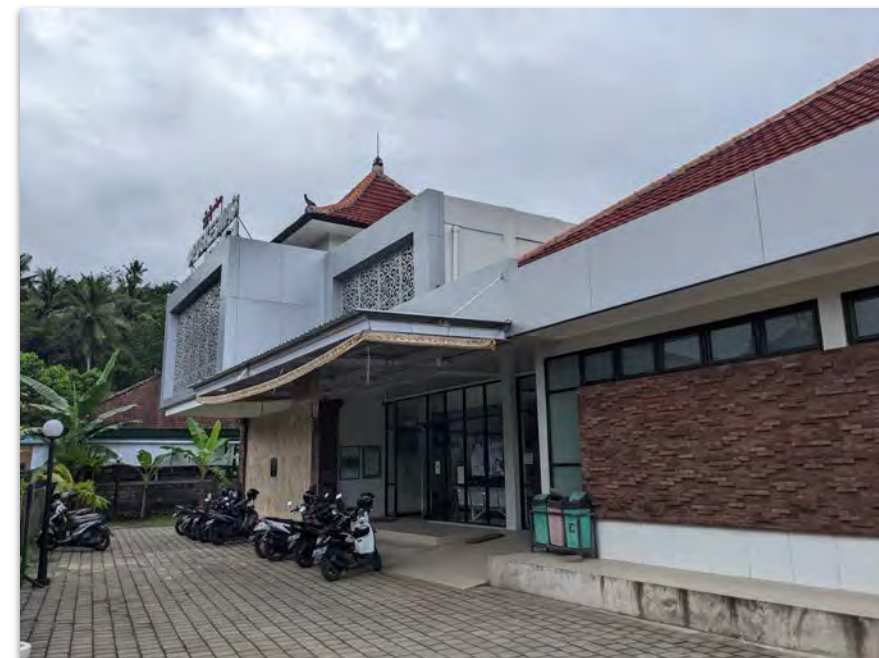
Community Health Center (Puskesmas) in Karangasem, Bali.
